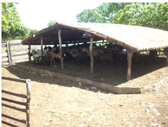
Instalações com piso de chão batido.
