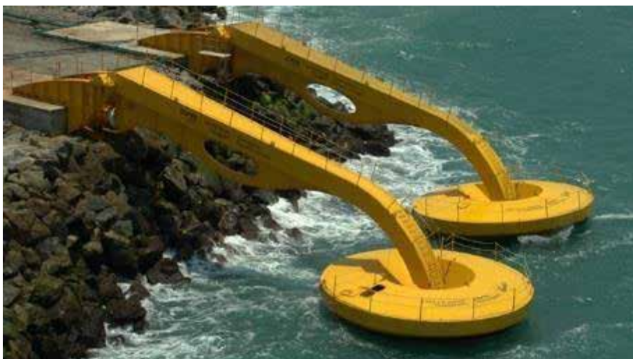
Figura 3 - Conversor de energia das ondas instalados no Porto do Pecém.
